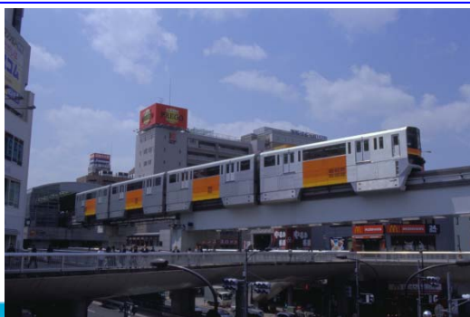
Estação Tachikawa Minami
