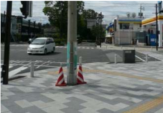
■ バリアフリー化された道路に電柱が存在している例
