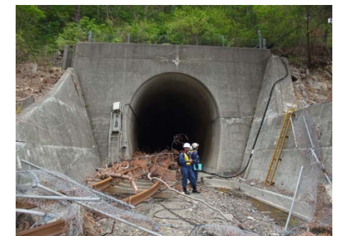
三陸鉄道の現地調査の状況
