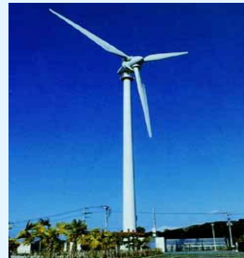
八丈島風力発電所
