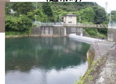
取水口に土砂が堆積
