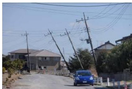
液状化に伴う電柱傾斜
