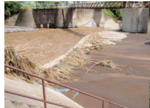
取水口に土砂が堆積
