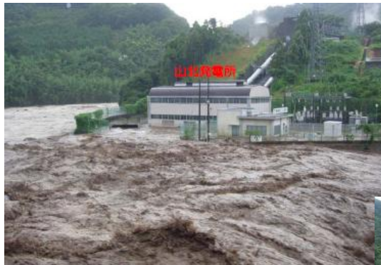
発電所への浸水
