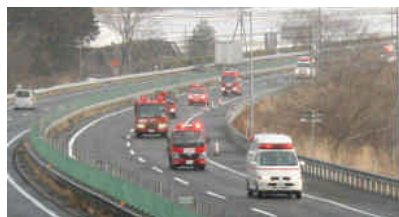
図6 緊急輸送道路として活用された高速道路(東北自動車道の例)
