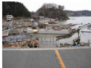
図2 寸断された国道45号 (南三陸町 国道45号 歌津大橋)
