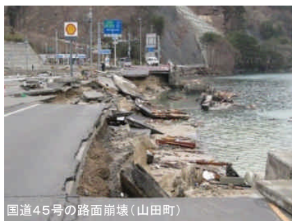
国道45号の路面崩壊(山田町)
