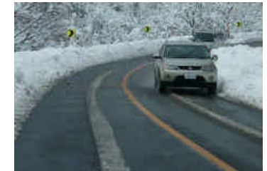
図6 線形不良箇所
