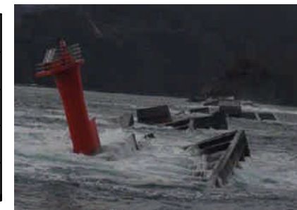
図5 津波で破壊された津波防波堤(釜石港)
