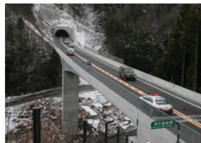
図7 高架で津波被害を免れた釜石山田道路
