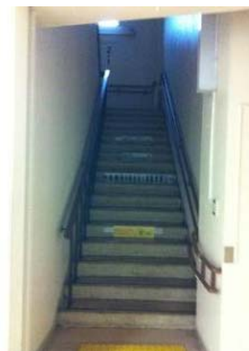
階段の踏面が26cm程度しかなく、スパンとの関係からスペース的にも改修が不可
