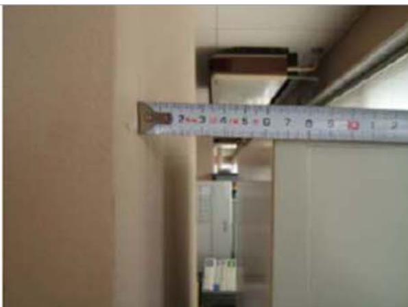
執務室内 : キャビネット(H1,690mm)上部 開き(65mm)→床の傾斜度約1/25
