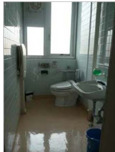
多機能トイレ: 車いす回転スペースなし
