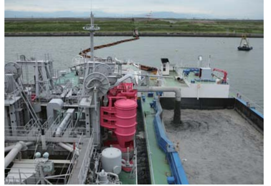
泥艙に溜まった土砂を中継ポンプ台船「輝龍」に移す。奥に見えるのは、土砂処分場のポートアイランド。
