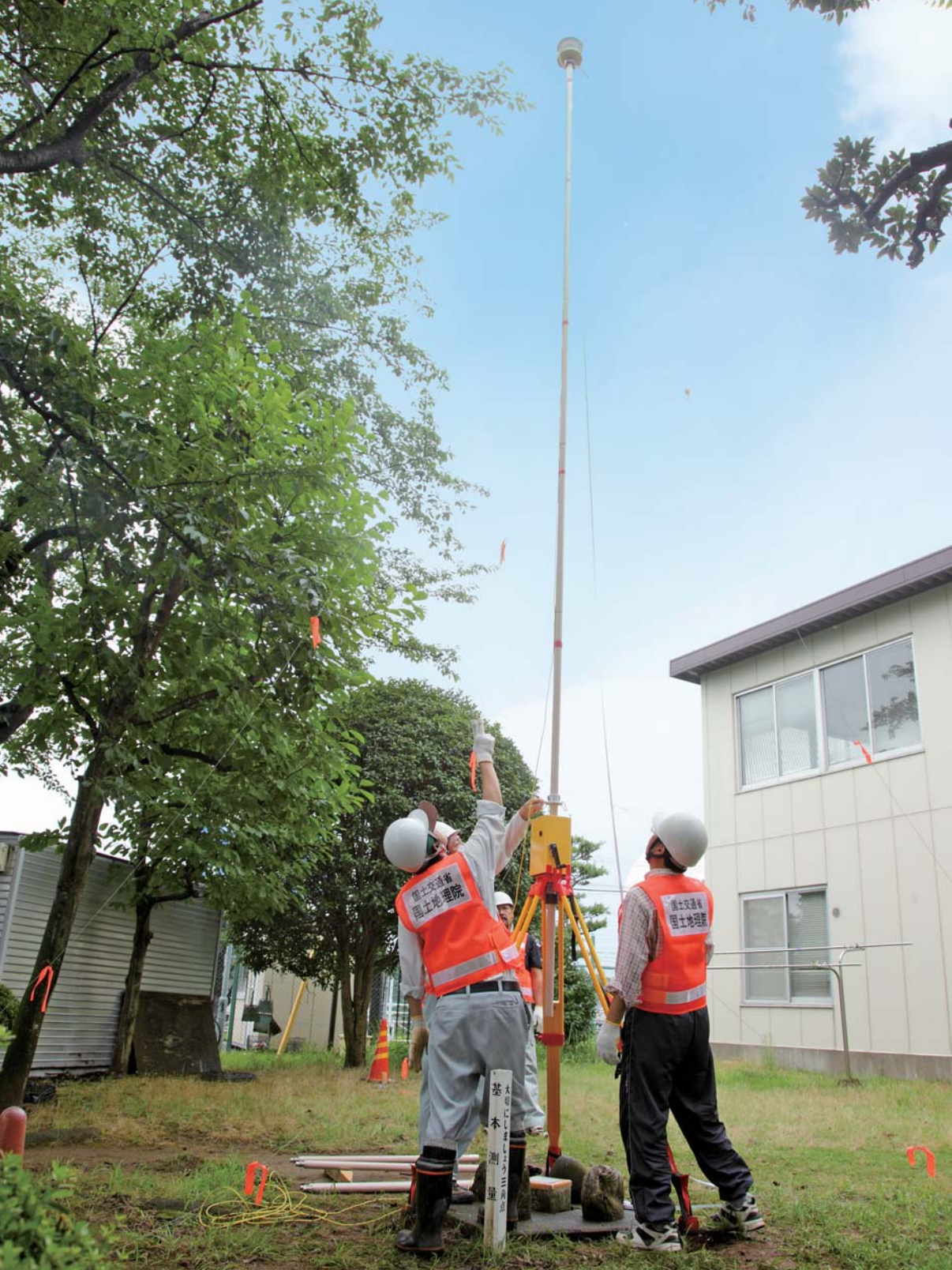
取手市にある一等三角点での測量。10mの高さにGPS電波の受信アンテナを設置。
