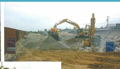
コンクリート塊破砕状況
