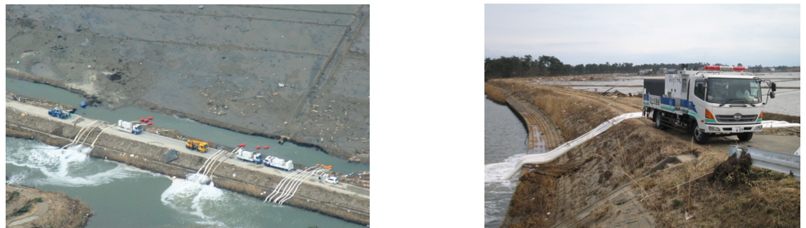
④ 排水ポンプ車の稼働状況
