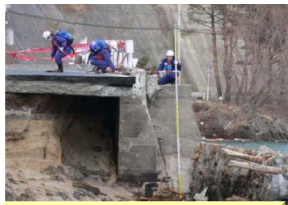
被災状況調査班(道路)
