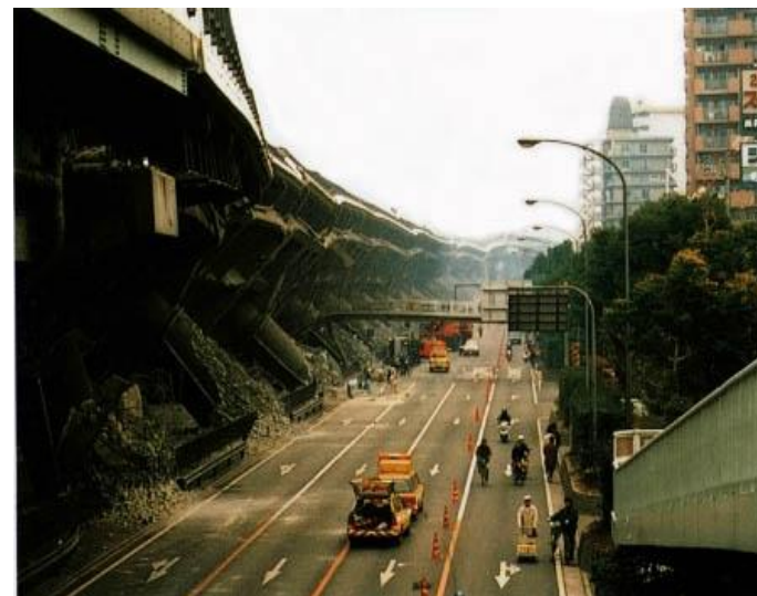
阪神淡路大震災での阪神高速道路の倒壊
