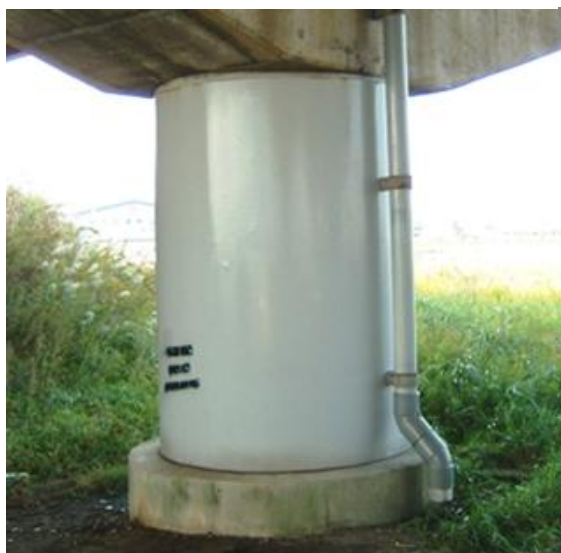
鋼板巻立て補強
