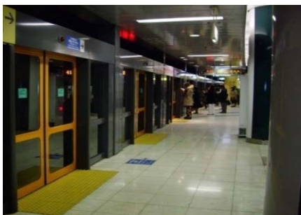
東京メトロ南北線 白金高輪駅のホームドア
