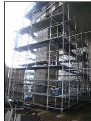
高架橋の耐震補強の例
