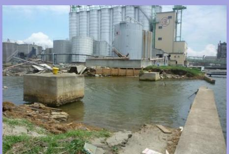
地盤沈下や護岸損壊による浸水の被害が甚大なサイロ(石巻港)
