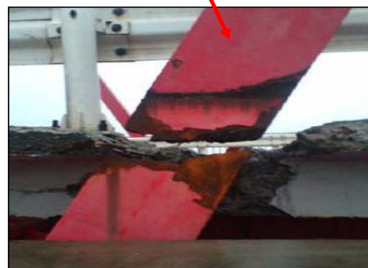
腐食で破断
