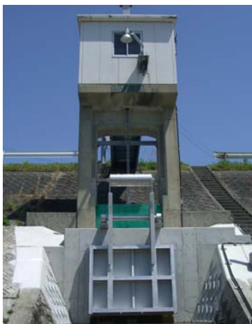
写真-3 津波対策として設置された例 菅第一樋門（仁淀川）2.0m×1.5m
