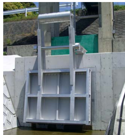
写真-3 津波対策として設置された例 菅第一樋門（仁淀川）2.0m×1.5m
