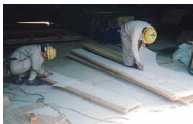
端型枠の製作 (K Kシート取り付け)
