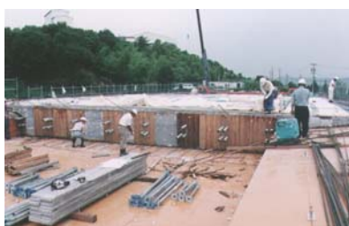
→ 端型枠の取りはずし
