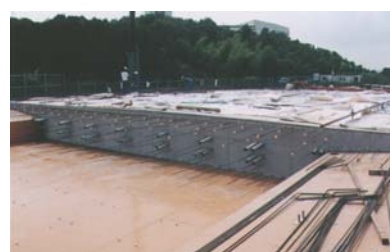
→ 打継面の完成
