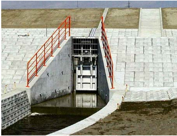
写真-1 豊城1号樋門（鵜川）平常時
