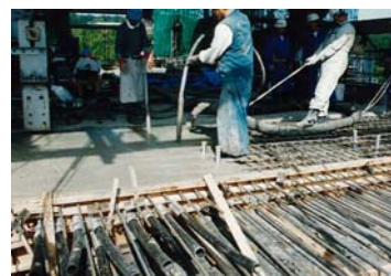
→ コンクリート打込み
