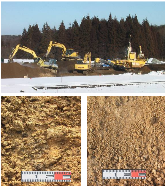
写真一 1 道路改良工事での稼働事例 上段： 盛土工区近くで稼働中のリテラ 下段： 左：原料土 右：改良土
