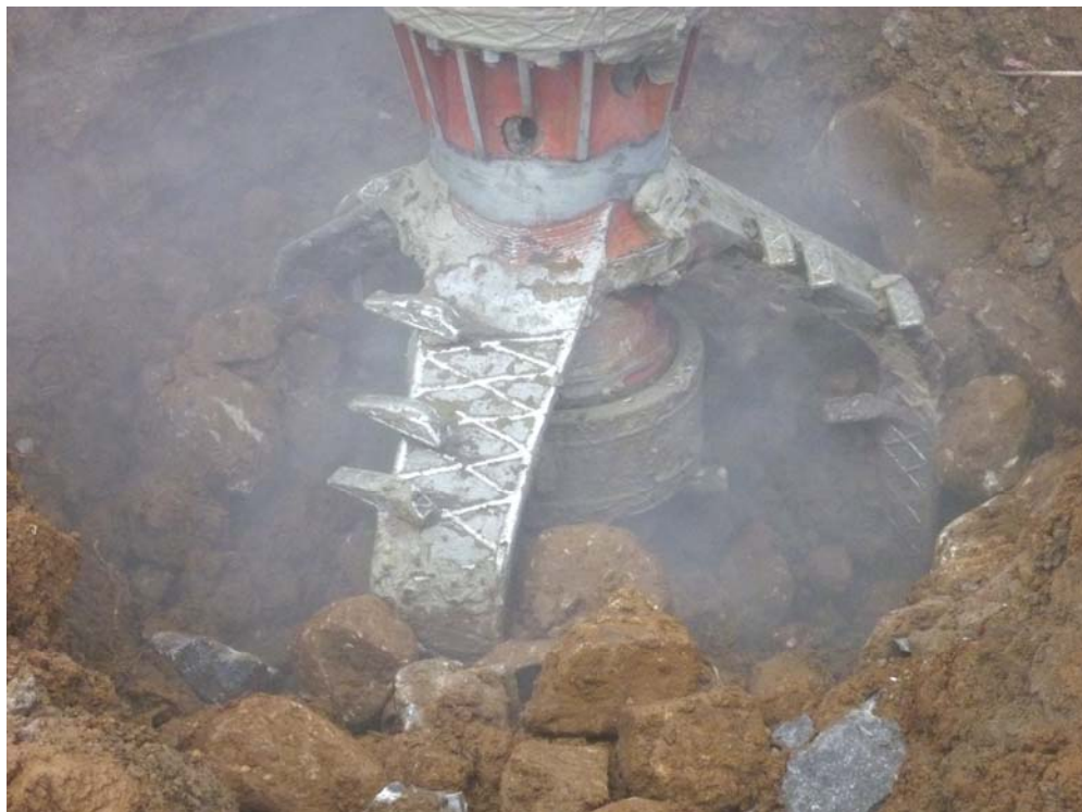
写真一 1 転石多量混在地盤 攪拌状況（最大転石径；φ500mm）
