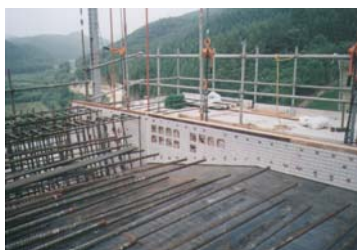
→ 端型枠の建て込み
