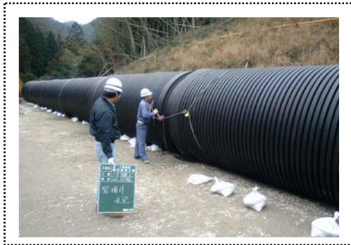
写真—1 接続作業状況
