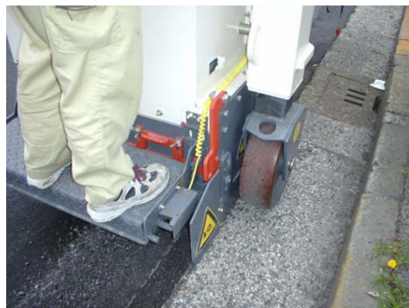
写真-2 道路幅端部 1段落とし切削中
