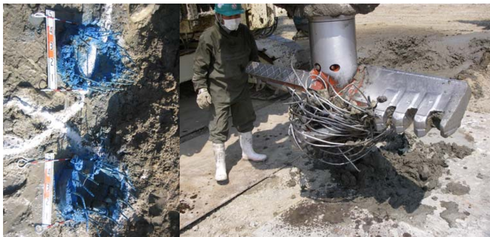
写真一 2 既製コンクリート杭破碎・改良同時施工状況（PHC杭；φ450mm）
