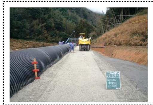
写真—2 締め固め状況
