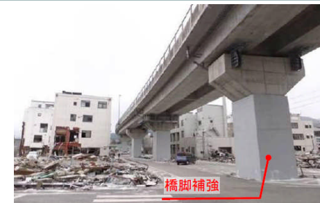
【耐震補強済み(鋼板巻立補強)地震動により損傷無し
