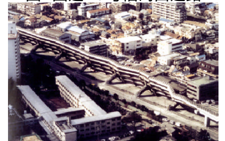
図 兵庫県南部地震被災状況
