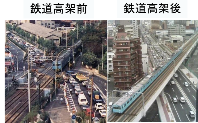
JR阪和線連続立体交差事業(大阪市)
