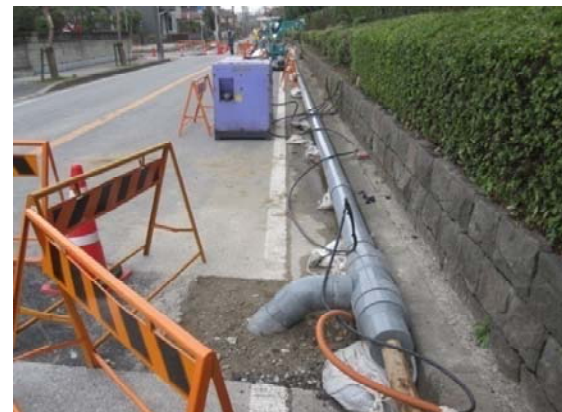
管きよのバイパス
