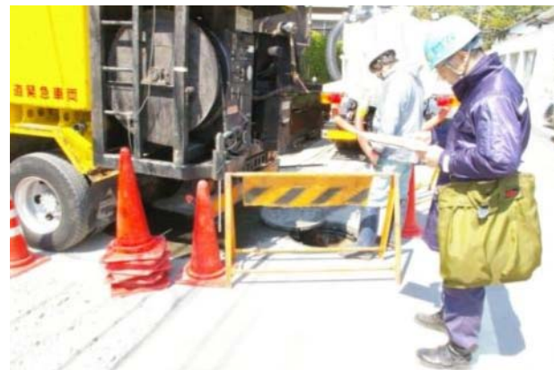
管路の被害状況の調査、清掃作業を行う職員
