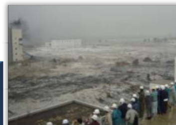
東北地方で最大規模の仙台市南蒲生浄化センター(処理人口約70万人)は津波により壊滅的な被害。
