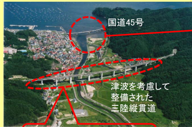
▲津波被害を受けなかった三陸縦貫道
