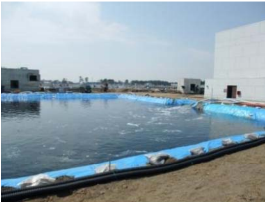
宮城県南浄化センター
