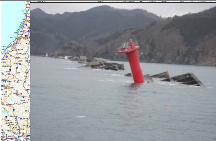
被災した釜石港津波防波堤(北堤)
