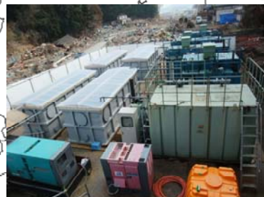
膜処理ユニットによる処理場と別位置での応急対応状況(陸前高田市)
