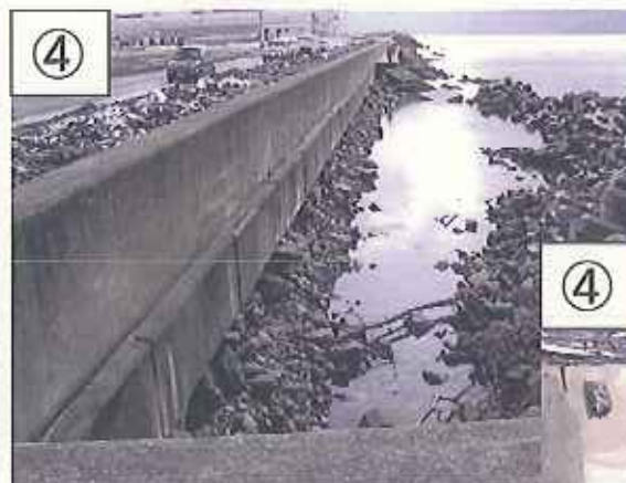
半崎1号護岸 ・基部 根ブロック71.6m、 被覆ブロック91.6m被災 ・捨石一部露出 ・終端部のパラベットの転倒倒壊あり
