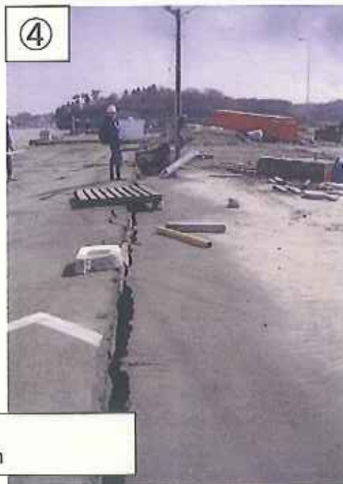
貞山2号棧橋 ・エプロン沈下0.2m
