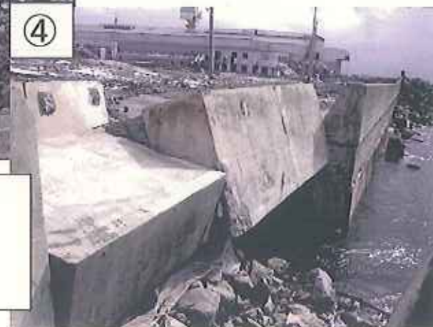
半崎1号護岸 ・基部 根ブロック71.6m、 被覆ブロック91.6m被災 ・捨石一部露出 ・終端部のパラベットの転倒倒壊あり
