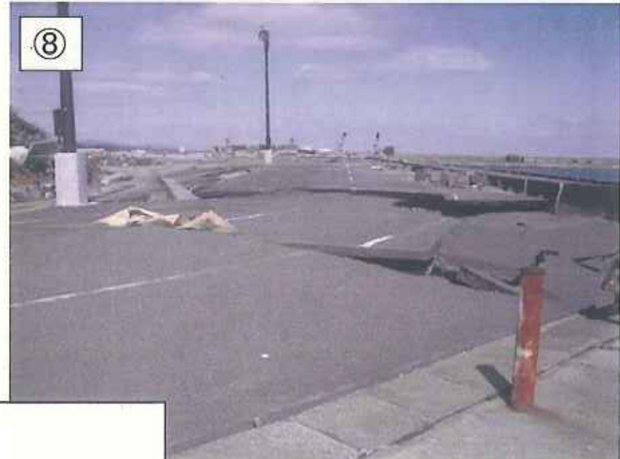
2号ふ頭第2号岸壁(-7.5m) ・部分的な倒壊、陥没 ・多目的クレーン海中に転落
