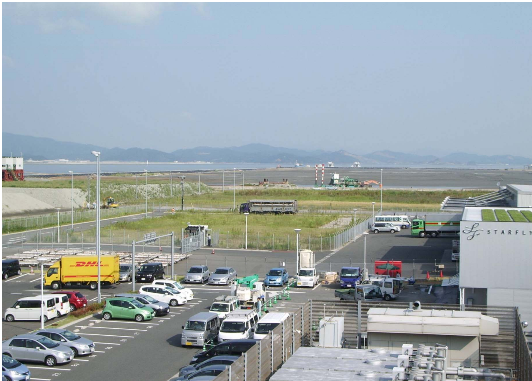
旅客ターミナル屋上から第3工区を望む
