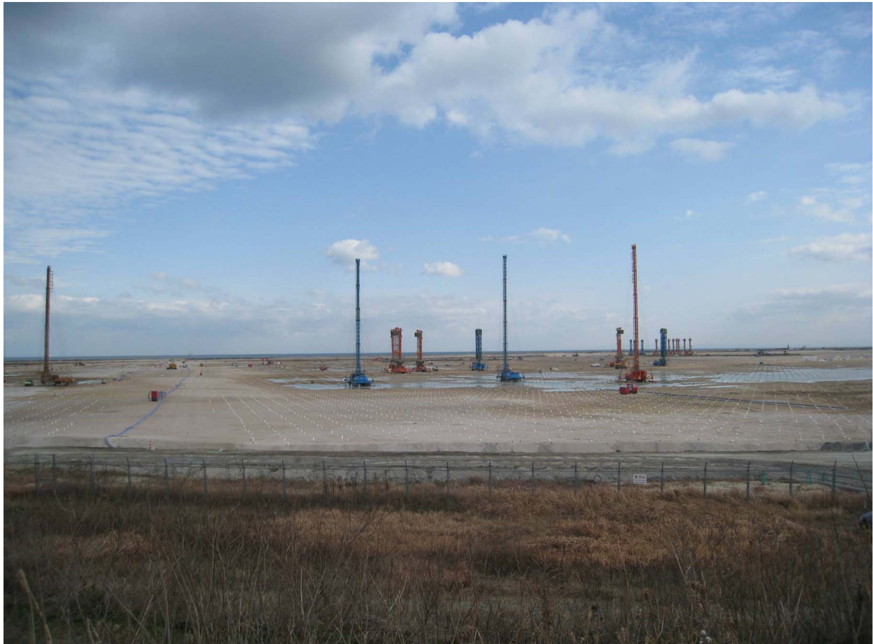
苅田沖土砂処分場地盤改良工事(平成23年1月)
