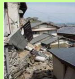
○多くの家屋が損壊被害
