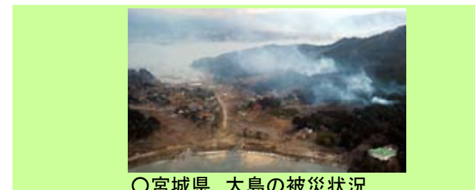
○宮城県 大島の被災状況
