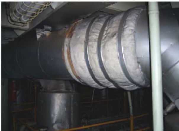
配管部分のアスベスト布団
