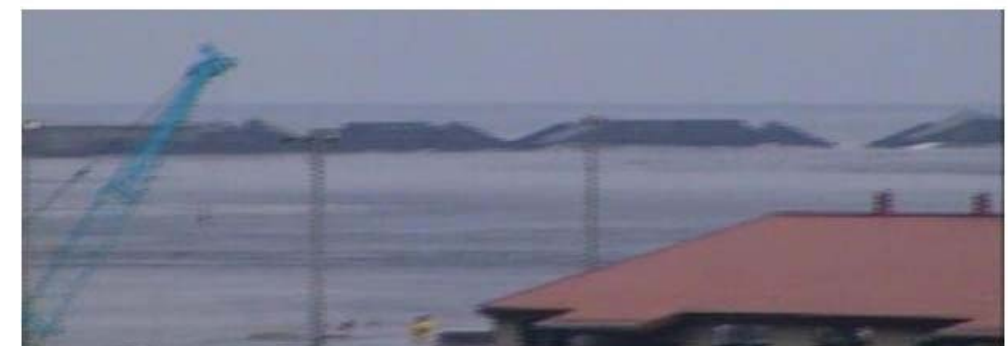
地震発生46分後：津波第1波が引き一部欠けた北堤 10
