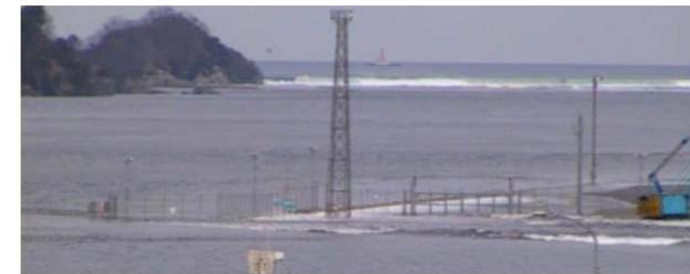
地震発生31分後：津波第1波が北堤を越流（斜下図）
