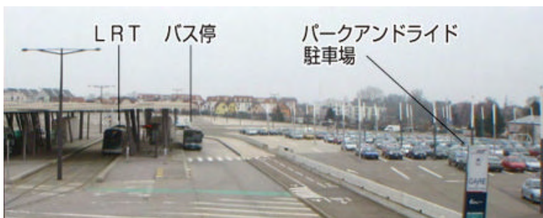
バス停、パークアンドライド駐車場を一体化したトランジットセンター
