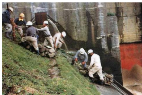
漏水状況(昭和57年9月洪水)
