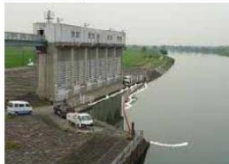
オイルマット設置状況
