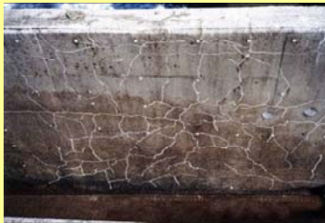
アルカリ骨材反応によるクラックの発生
