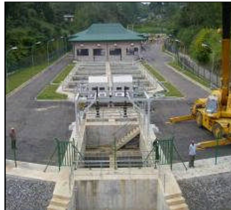
Intake Pump Station (Kandy)
