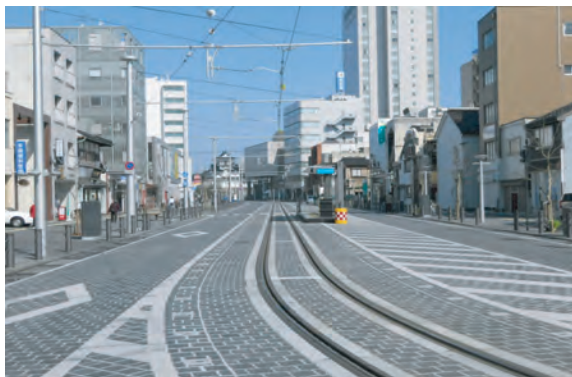
〔基幹事業〕走行路面、架線、停留場
