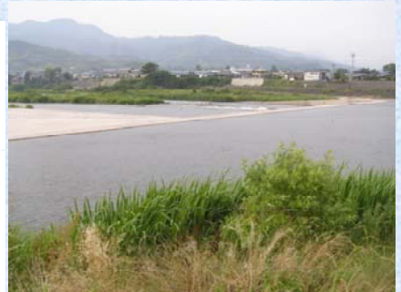
弾力的管理試験実施中の大石堰上流 (平成17年6月17日)
