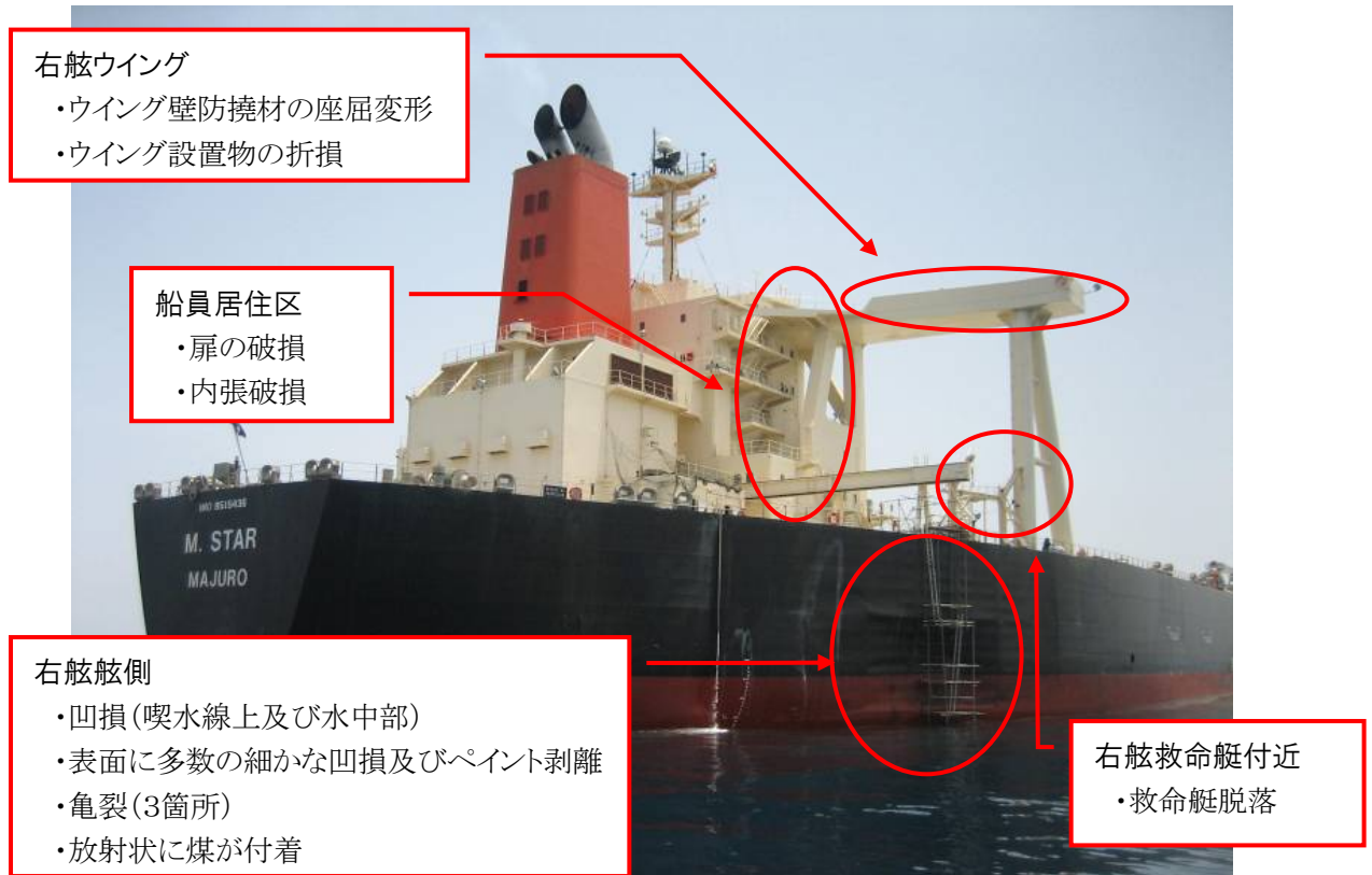
図5-1 船体の損傷状況
