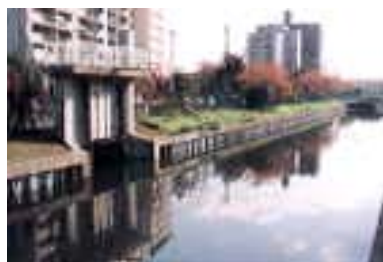
城門放流幹線水門
