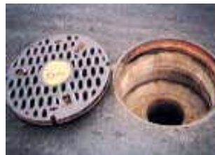
新設海水取水口
