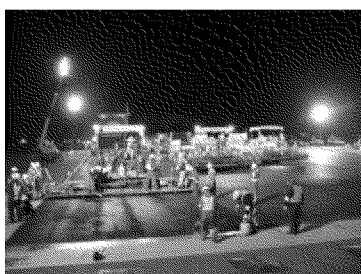
（滑走路舗装の改良）
