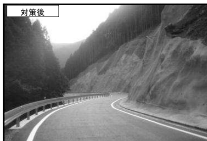
直ちに法面保護工事を実施し、次期豪雨期までに交通の安全を確保
