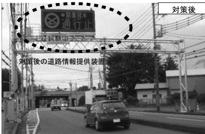
直ちに道路情報提供装置を改良（視認性の向上）し、早急に事故の再発を防止
