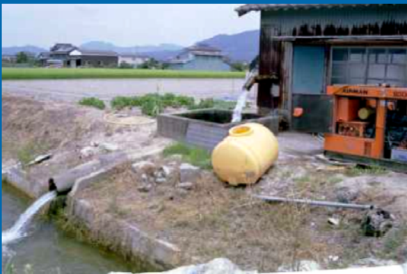
深井戸からの揚水状況
