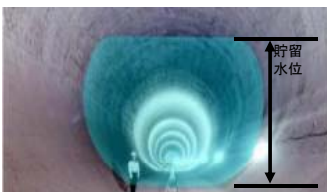
地下調節池の整備 (東京都 環状七号線地下調節池)
