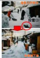
雨水排水路の活用
