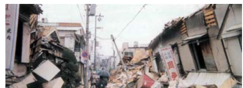
建物倒壊により道路(避難路)が閉塞
