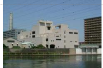
ポンプ場の整備 (東京都神谷ポンプ場)
