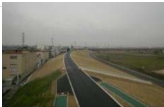
堤防の整備 (東京都 荒川)
