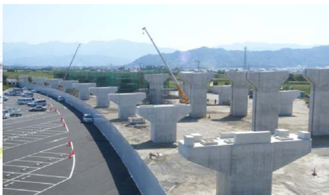
図 松山外環状路道路工事の様子
