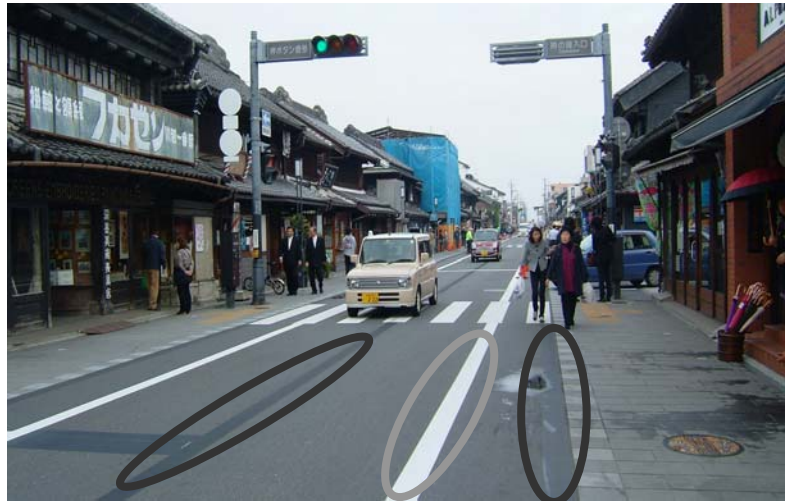
消去した既存のセンターライン 実験用に設置した外側線 消去した既存の外側線 社会実験時の一番街
