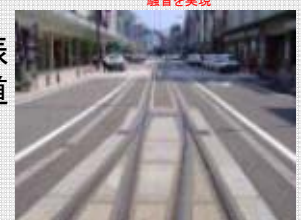
福井鉄道市内軌道福井駅前付近 インパンド軌道を採用し、低振動・低騒音を実現
