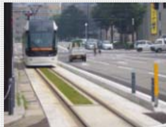
富山ライトレール富山駅北付近 軌道敷地と車道を緑石により分離
