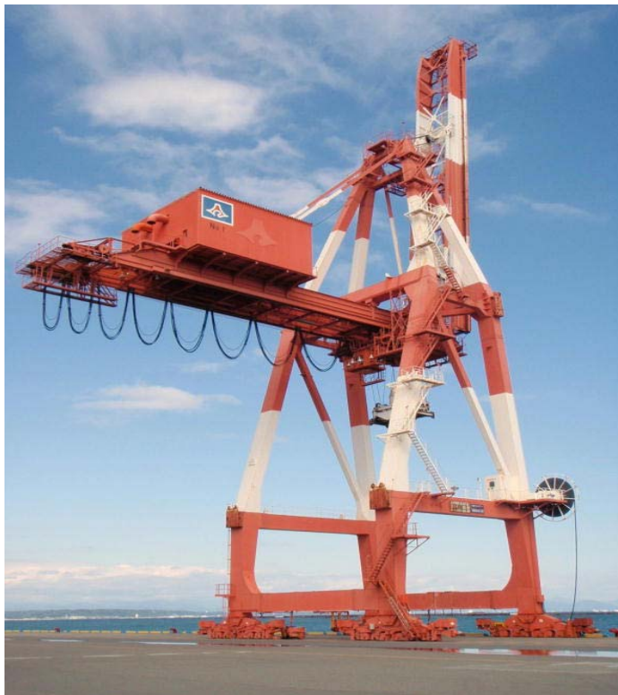
【御前崎港女岩埠頭－1 4 m岸壁コンテナクレーン1号機】
