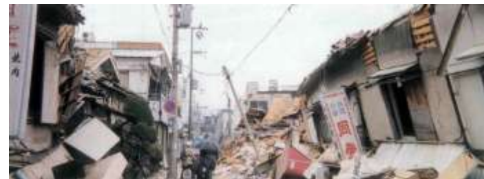
建物倒壊により道路（避難路）が閉塞
