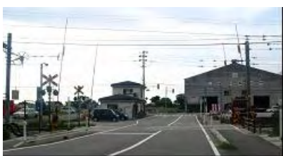
■写真 3.2.3 踏切の拡幅(道路事業)
