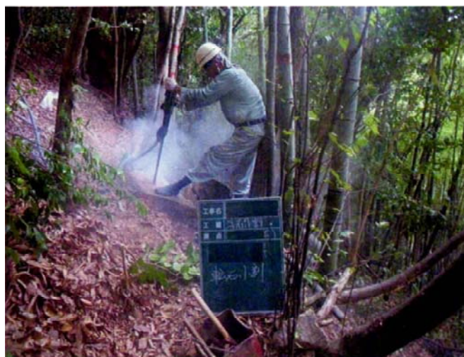
点検後に実施された転石の撤去状況
