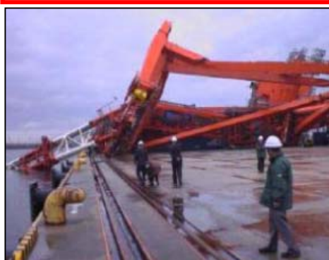
※クレーン逸走事故の事例参照
