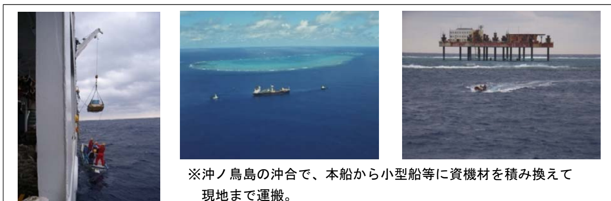
沖ノ鳥島における保全工事等の作業の現状
