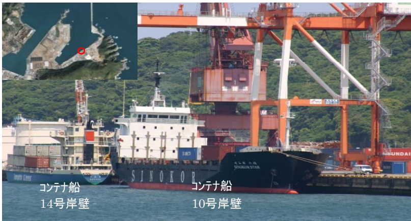
■10号岸壁(水深10m)、14号岸壁(水深13m)を定期コンテナ船が同時利用しているため、大型バルク船の利用は困難である。
