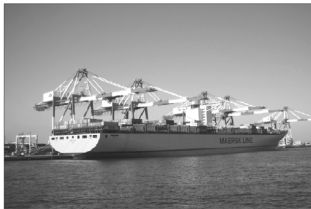
【横浜港 南本牧コンテナターミナル(MC-2)】
