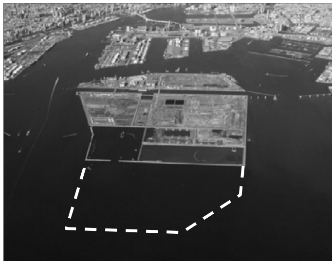
【東京港 海面処分場】
