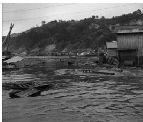
【津波による家屋の浸水状況】
