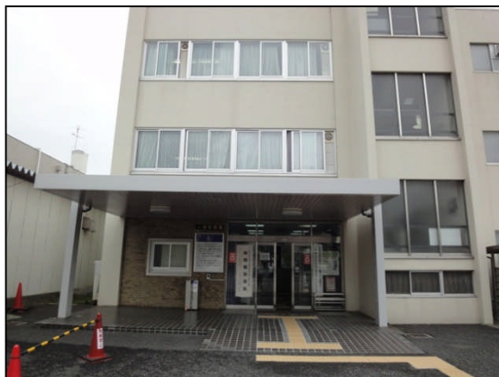
玄関庇前 : EV設置スペース無し
